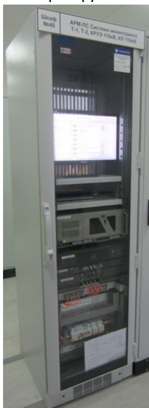
Рисунок 1 - Пример установленного шкафа КМК-1
