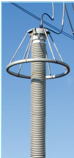
**Система «OPN-Monitor» предназначена для организации мониторинга технического состояния высоковольтных ограничителей перенапряжений (ОПН).** Контроль технического состояния ОПН осуществляется по величине тока проводимости, его гармоническому составу, и мощности импульсов, прошедших через ОПН.
