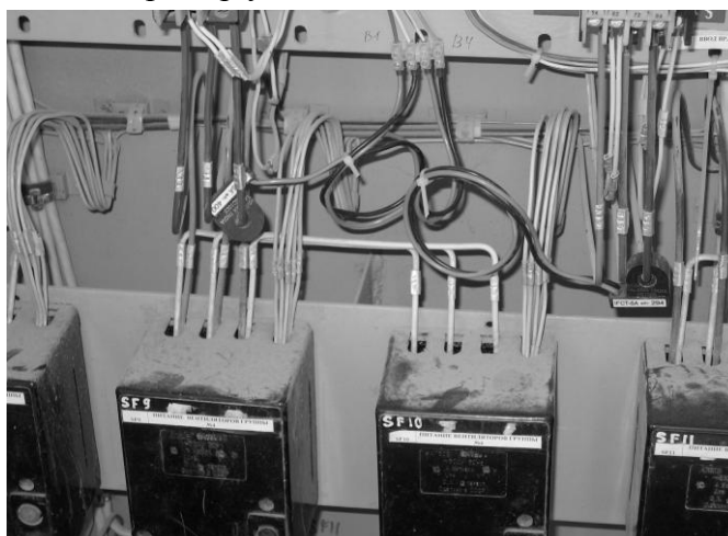
Рисунок 3.7.3. Пример установки датчика «IFCT-5A».
